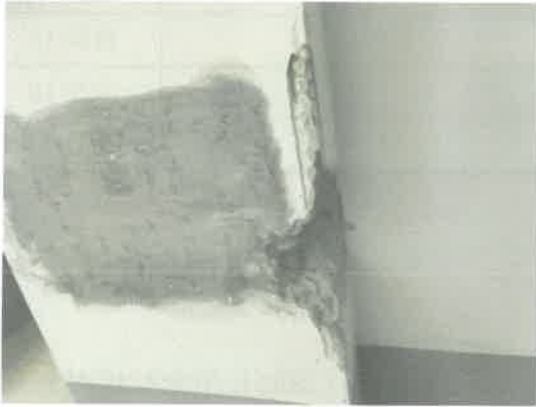
照片 7.2.1 构件主筋、箍筋测量
