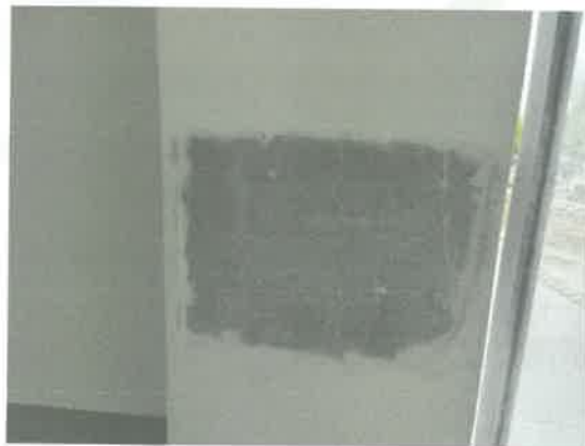
照片 7.5.2 混凝土测区
