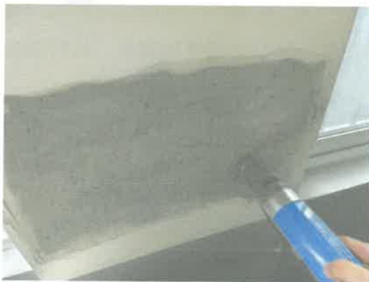
照片 7.5.1 混凝土强度检测
