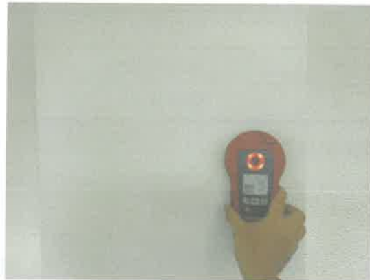
照片 7.2.2 构件钢筋测量
